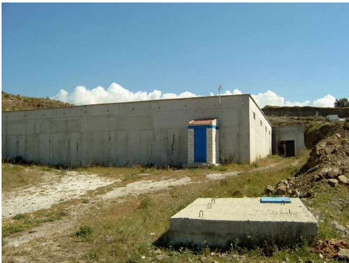
Depósito de agua de El Romeral en Vélez-Málaga. / Aqualia
