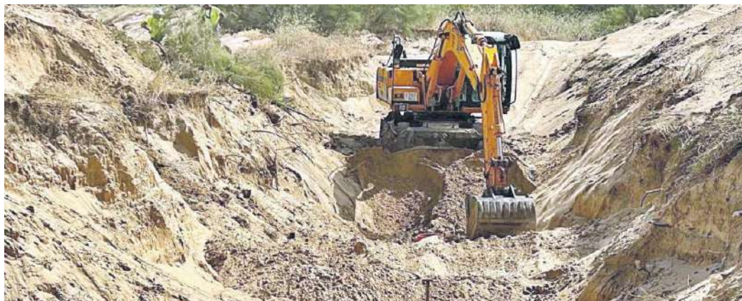
Maquinaria de Aqualia actúa en el colector de Bonanza.
